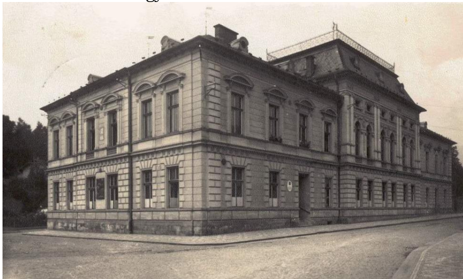
Budova Reálného gymnázia – dnes ZŠ J. Harracha.
